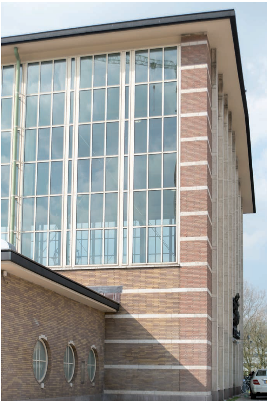
De bakstenen gevel met natuurstenen speklagen.
